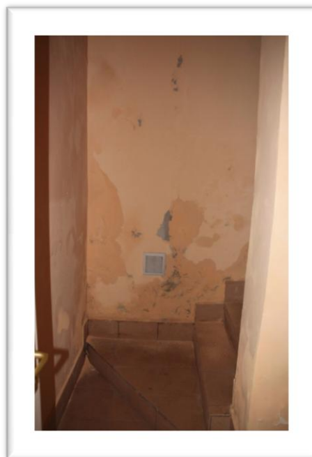
Fot. Nr 6 i 7 łuszczące się zawilgocone powłoki tynków w piwnicy
