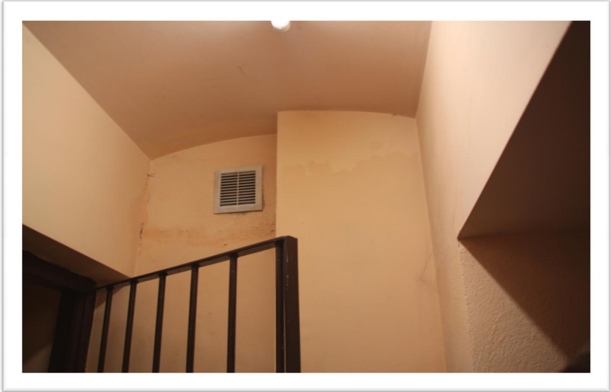
Fot. Nr 11 Kratka wentylacyjna na poziomie parteru
