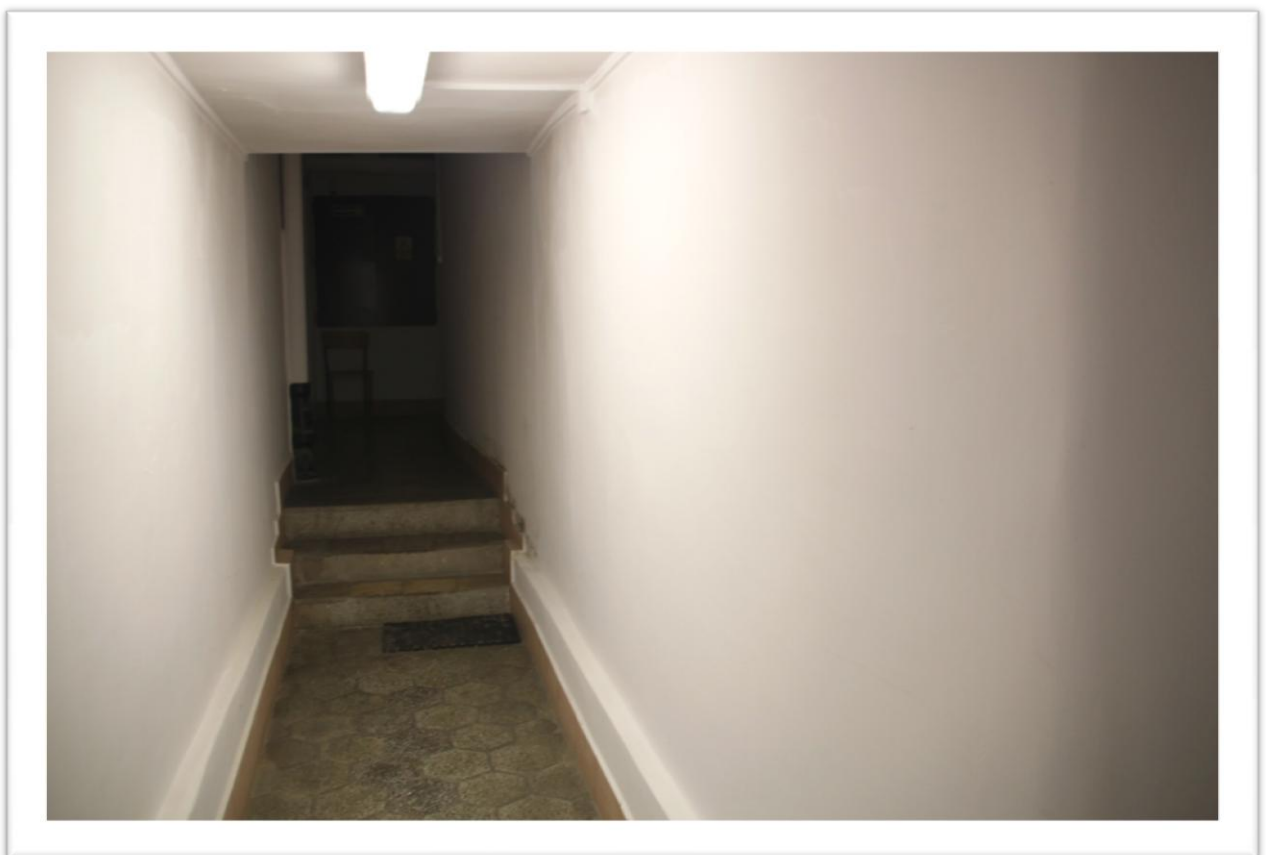
Fot. Nr 18 i 19 Powłoki ścian do skrobania i malowania- korytarz w piwnicy sądu.
