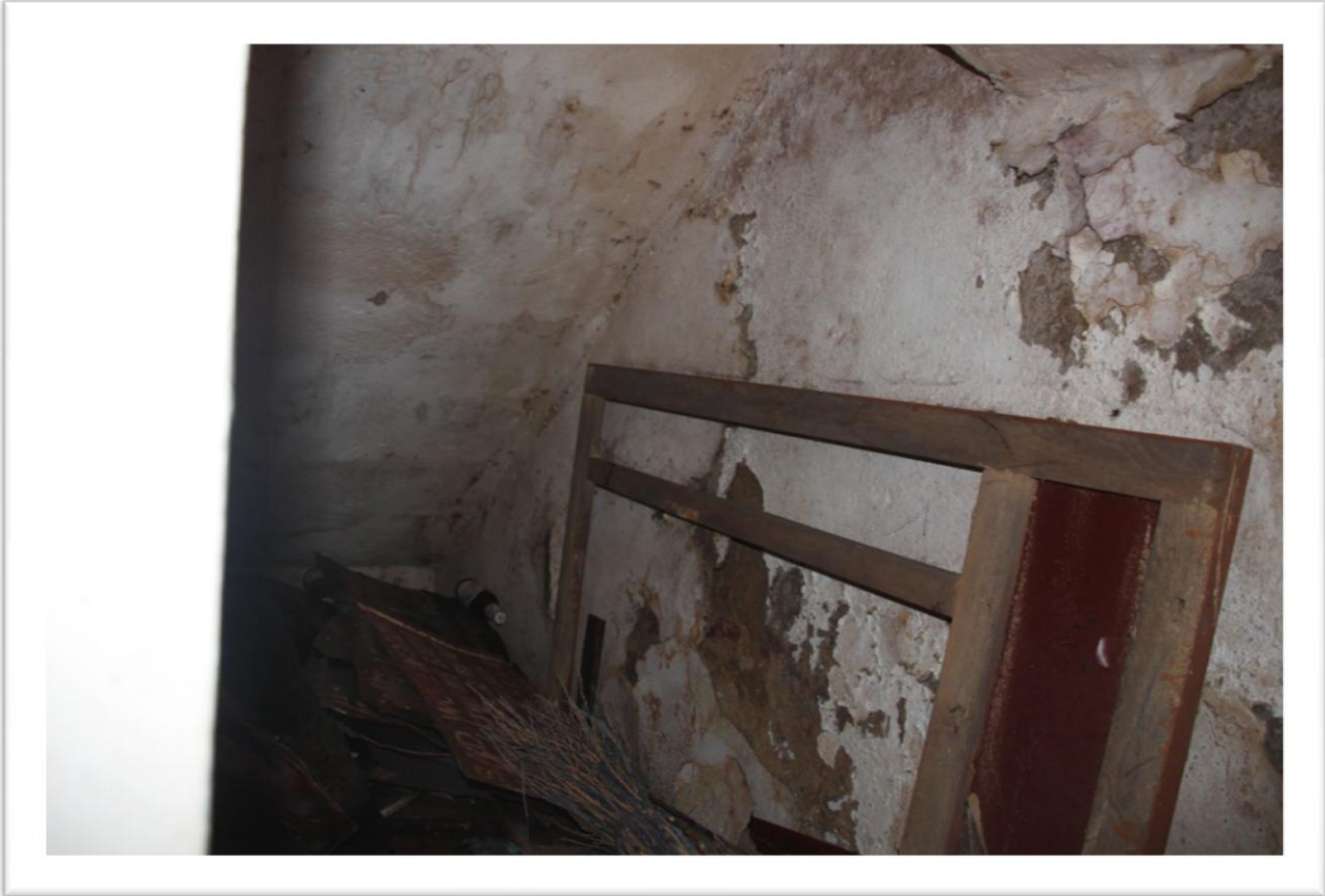
Fot. Nr 12 Schowek pod schodami do piwnicy
