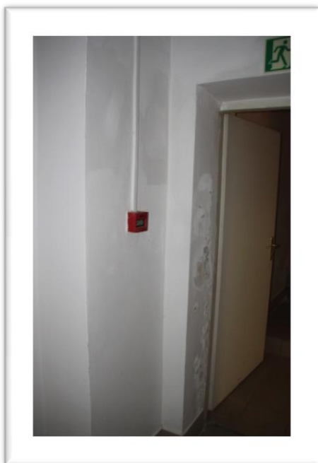
Fot. Nr 6 i 7 łuszczące się zawilgocone powłoki tynków w piwnicy
