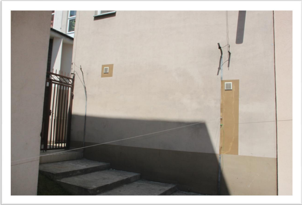
Fot. Nr 24 Położenie kratki wentylacji wyciągowej i wywiewnej na zewnątrz budynku
