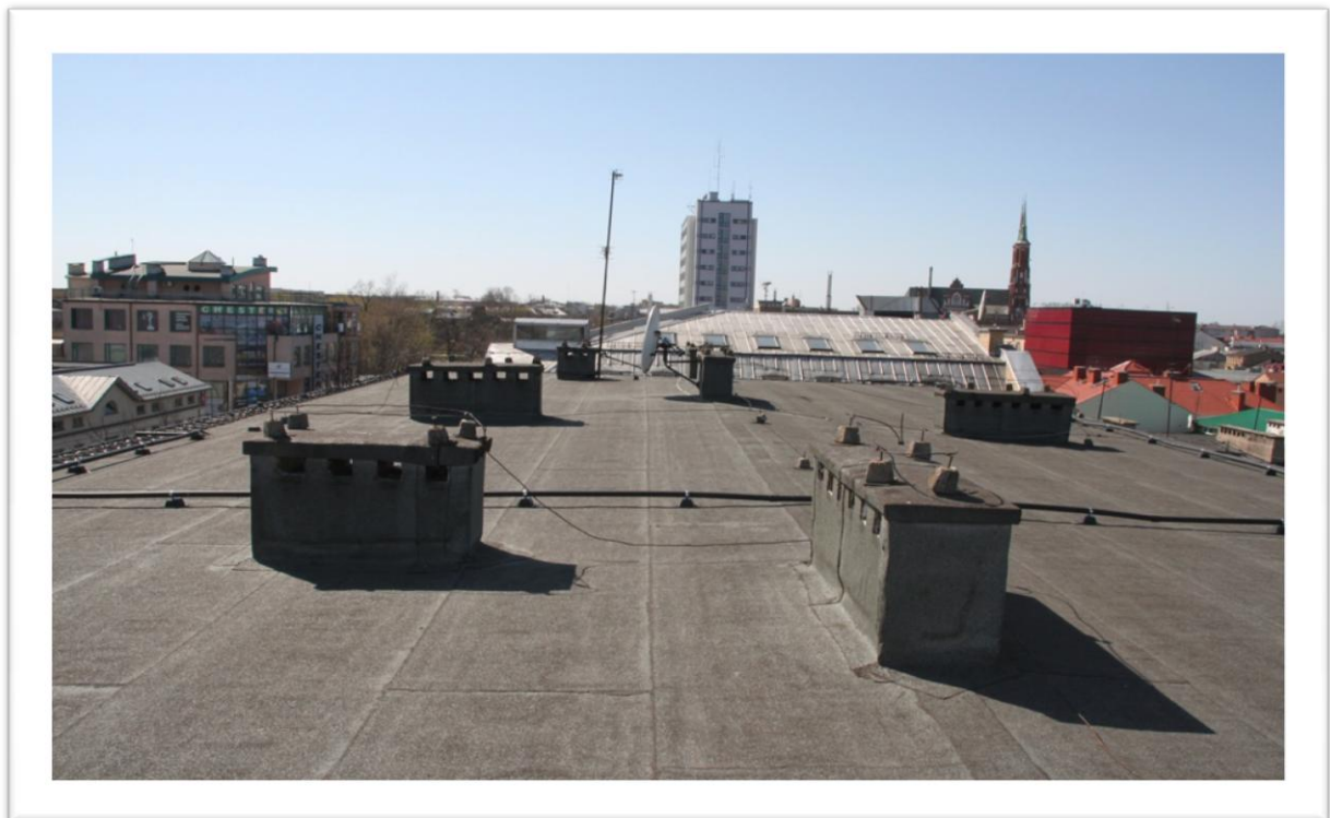
Fot. Nr 2 Dach budynku A Sądu.
