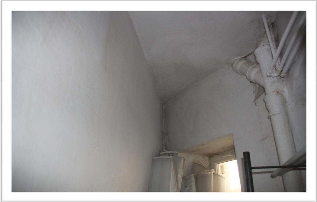
Fot. Nr 23 Pomieszczenie magazynu.
